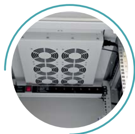
Chłodzenie szafy panelem 6-wentylatorowym
