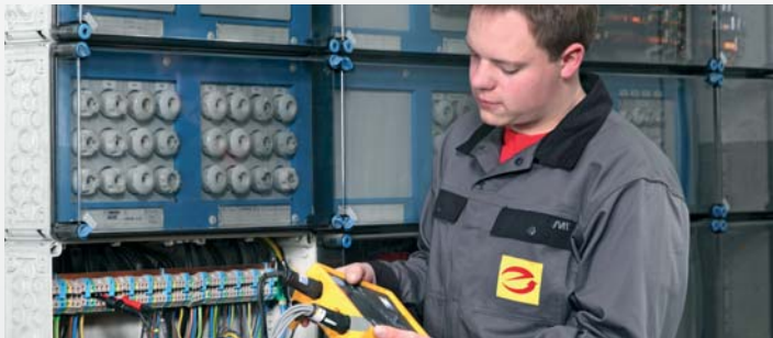
Rozdzielnice do 630 A jako zestawy rozdzielcze lub sterownicze (PSC) według PN-EN 61439 część 2
