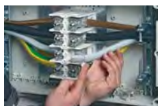
Pokrycie końcówki przewodu wazeliną techniczną
