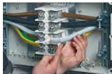
Pokrycie końcówki przewodu wazeliną techniczną
