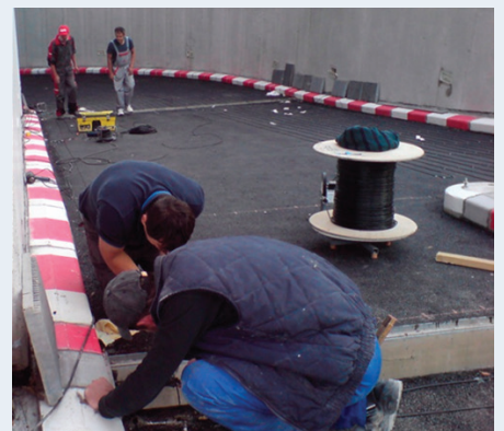
Wjazd do garażu podziemnego, Ljubljana, Słowenia
