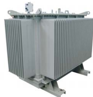
Dławik TKFC 500 kVA wykonanie hermetyczne
