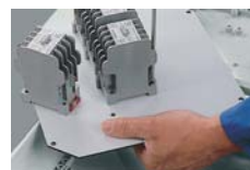
Montaż aparatury na płycie montażowej
