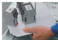
Montaż aparatury na płycie montażowej
