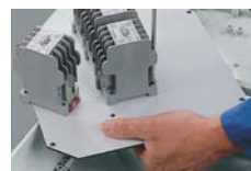
Montaż aparatury na płycie montażowej
