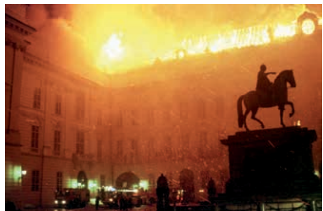
Rys. 63 Pożar zamku Hofburg (Wiedeń, 1992)
